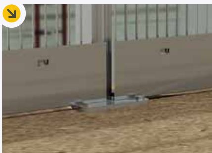
MONTAGE OP SPANPLAAT
