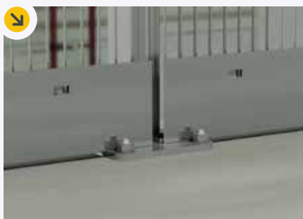
MONTAGE OP BETONNEN VLOER
